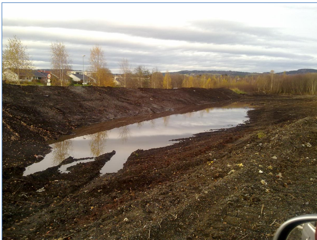
Grunnvann ved støyvoll mot Fv 757.
