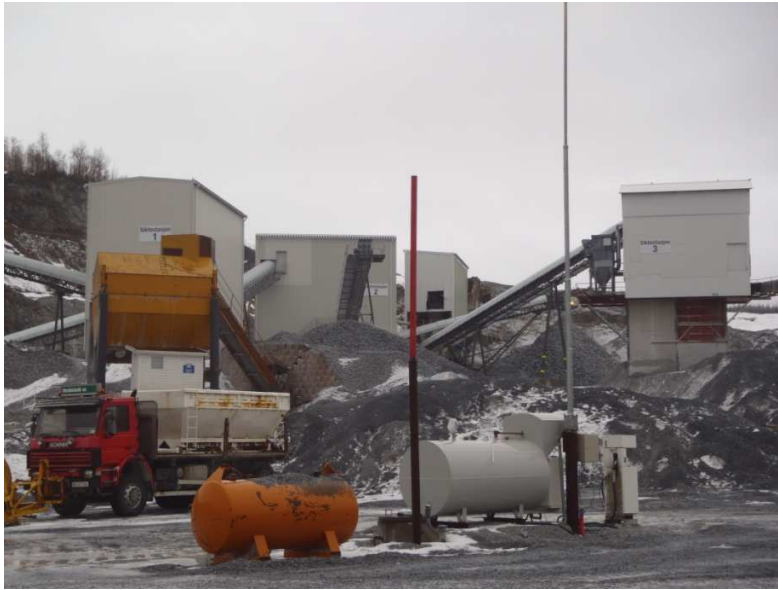
Bilde 3 - Oversikt over deler av anlegget. 3 av husene er merket sikt 1, 2 og 3
