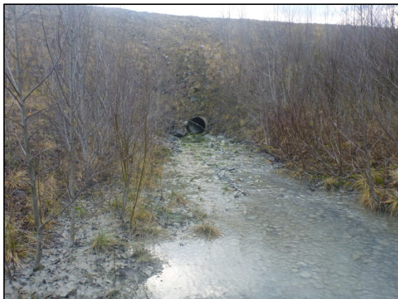
Figur 7: Utløpet fra sedimentasjonsbassenget. Bilde tatt på befaring 10. november 2014.
