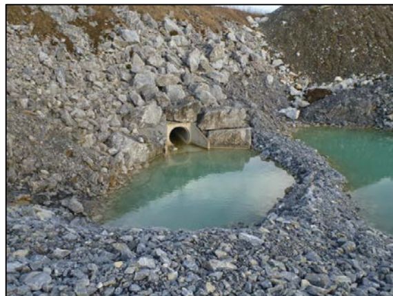
Figur 6: Sedimentasjonsbasseng med utløp til Trongdøla. Bilde tatt på befaring 10. november 2014.
