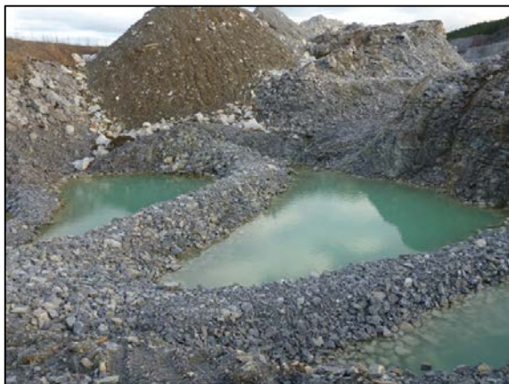
Figur 5: Sedimentasjonsbasseng med terskler. Bilde tatt på befaring 10. november 2014.
