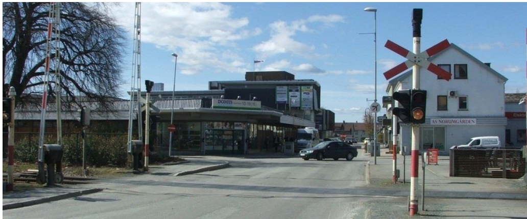
- Planovergangen i Nordgata sett fra øst mot vest
