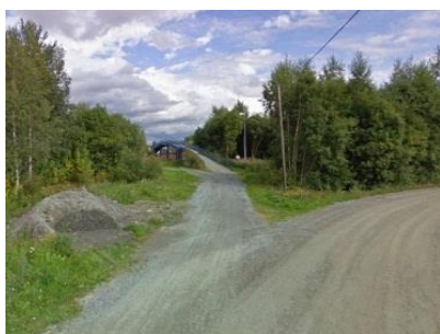
- E6-brua sett fra Ørin
