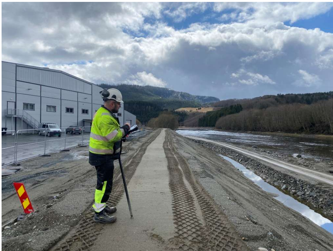
Figur 36: Kontroll høyder på flomvoll. Anleggsvei på utsiden av flomvoll.
