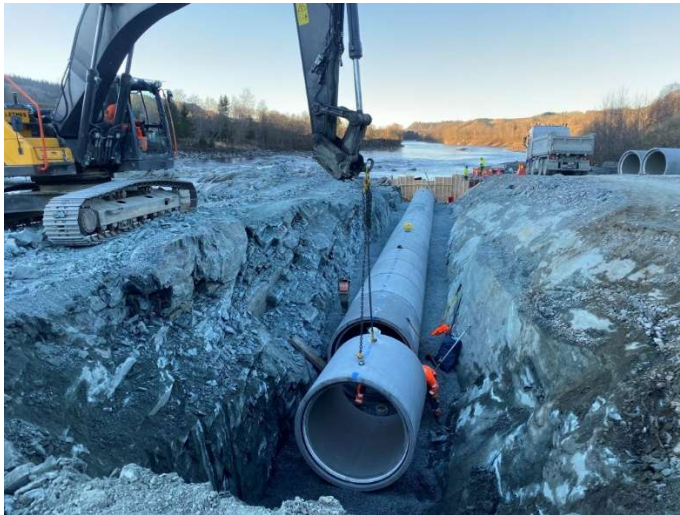
Figur 9: Legging av kulvert basal 1600mm i utsprengt grøft
