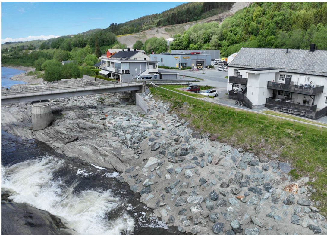
Figur 25: Avslutning imot bru over Østnesfossen
