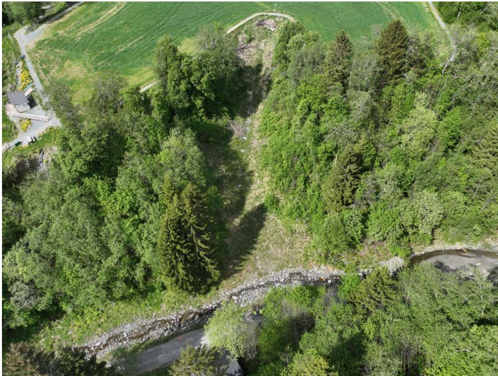
Figur 43: Erosjonssikring Ekerbekken, øvre ende til høyre i bildet
