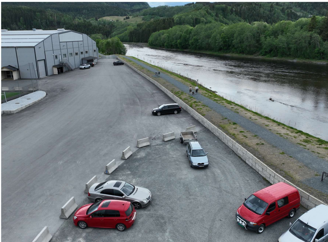
Figur 31: Sagamur mot parkeringsplassen ved idrettsområdet
