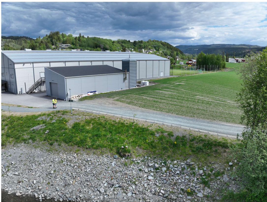
Figur 17: Overgang flomvoll på land og mot Verdalselva. Avslutning erosjonssikring til høyre i bildet.
