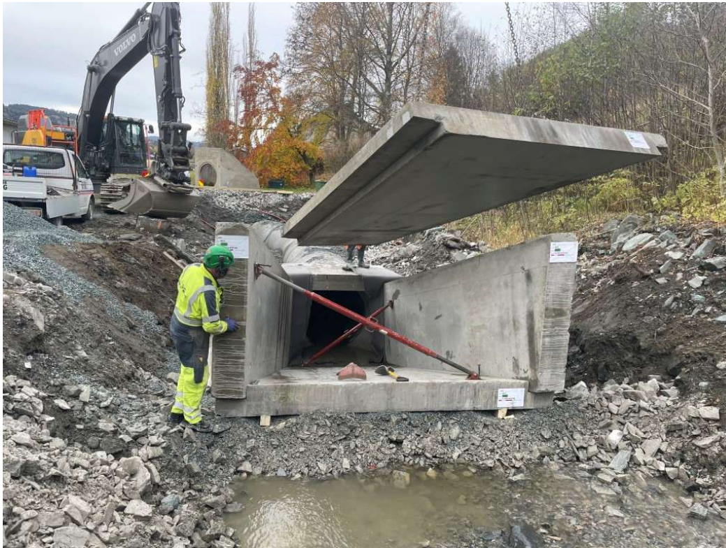
Figur 47: Nytt innløpsarrangement under bygging
