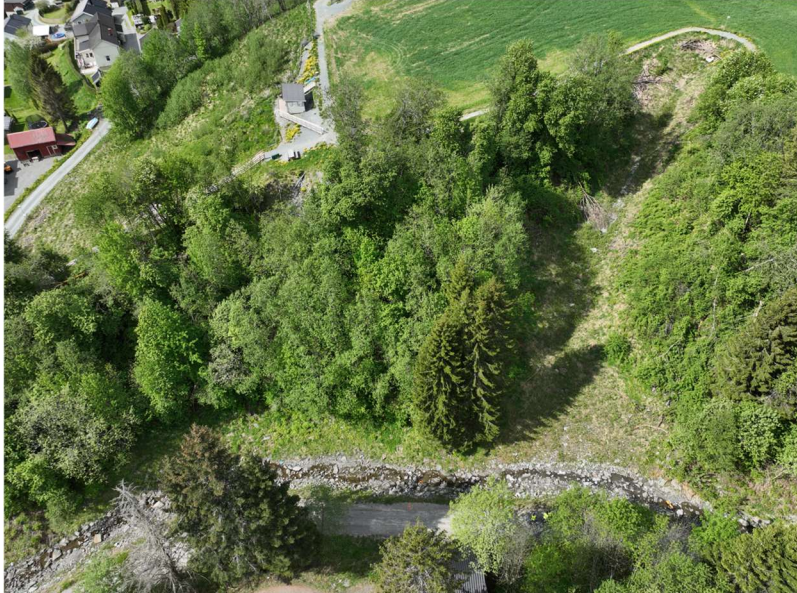
Figur 5: Erosjonssikring Ekerbekken og sideravine ved P25
