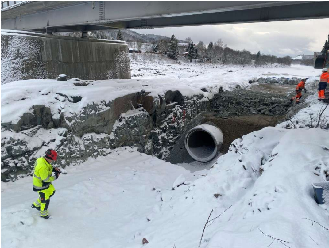
Figur 41: Ny kulvert, basal 1600, med omfyllingsmasser
