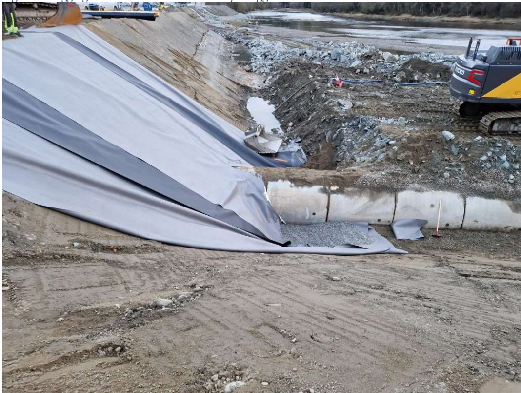
Figur 33: Tettemembran rundt basal 1600.
