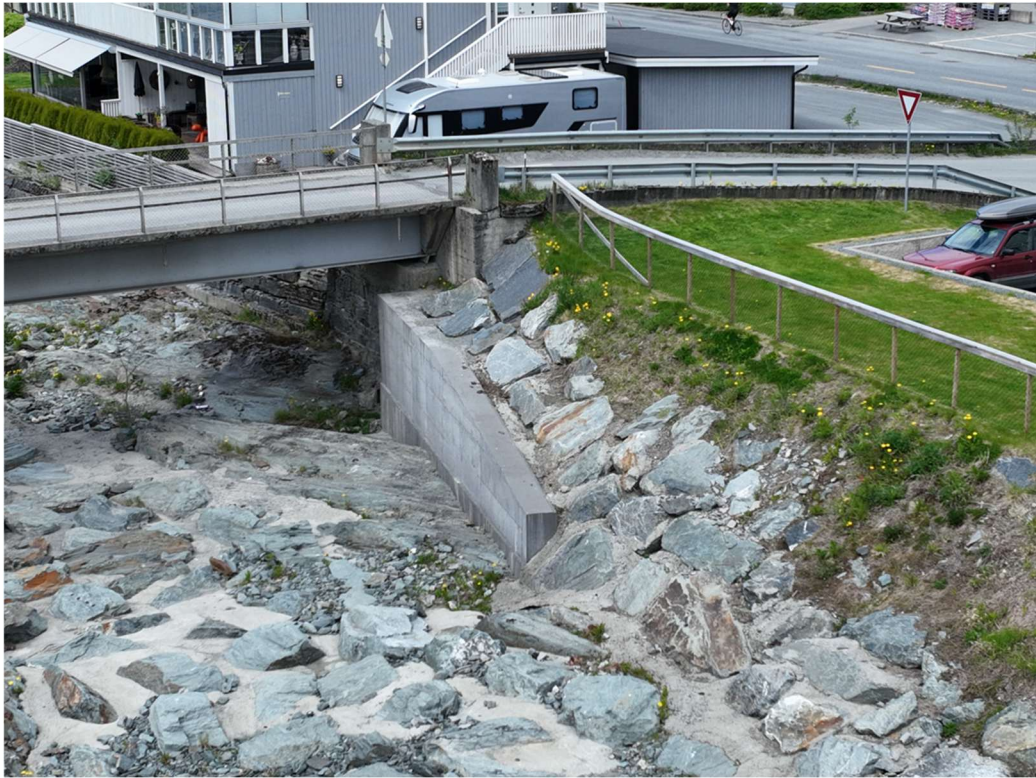
Figur 26: Avslutning med støpt mur imot brufundament. Solid plastring av flomvoll og utsprengt grøft til basal 1600
