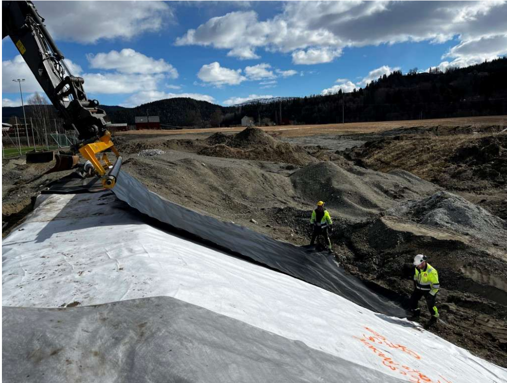
Figur 32: Legging tettemembran. Filterduk kl. 5 på begge sider av tettemembran
