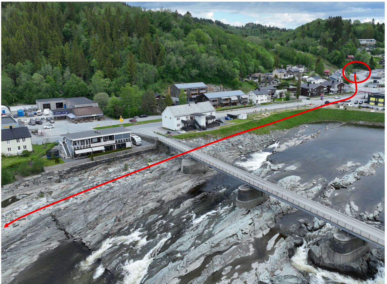
Figur 38: Innløp kulvert og ca. plassering ny kulvert Ekerbekken øverst til høyre i bildet. Bildet viser ferdig tiltak.
