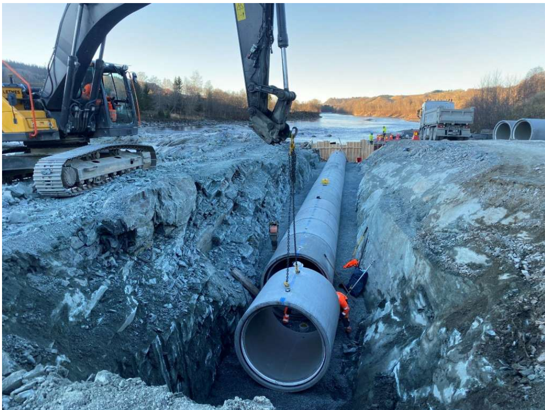
Figur 40: Ny kulvert, basal 1600, i utsprengt kanal
