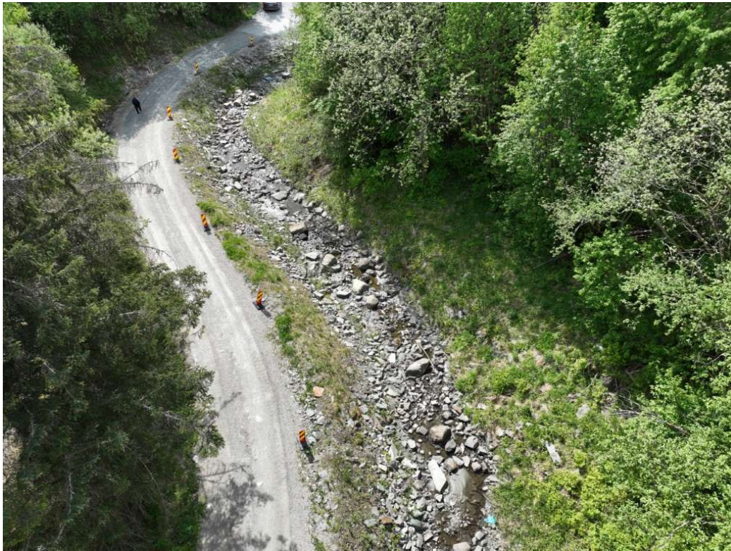
Figur 45: Erosjonssikring Ekerbekken
