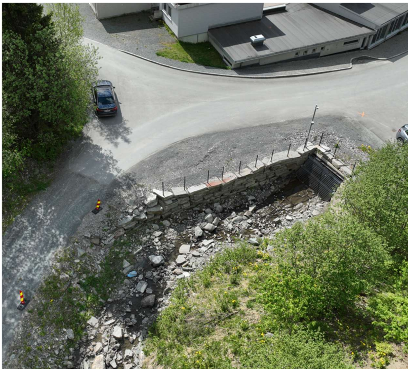
Figur 6: Innløp kulvert Ekerbekken, tørrmur venstre side.
