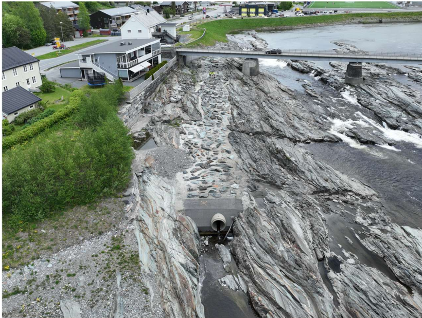
Figur 37: Utløp ny kulvertrase for basal 1600 mm. Beskyttet utsprengt trase med topp sikring av stein og betong. Se vedlegg I-3 for teknisk notat som beskriver endekloss
