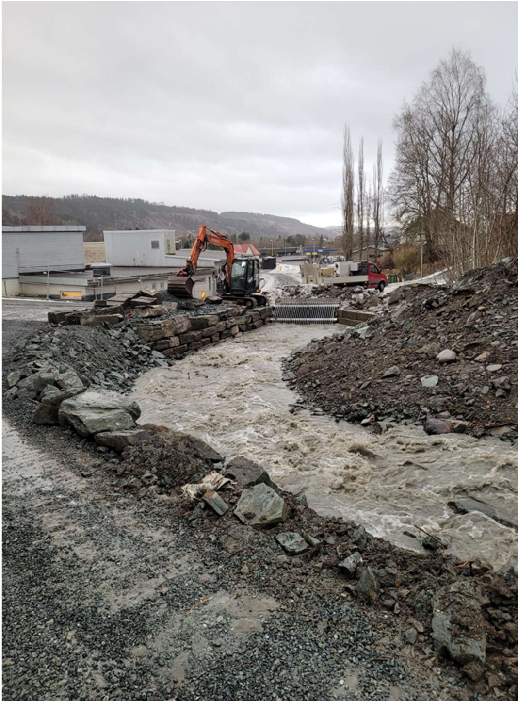
Figur 49: Stor vannføring i Ekerbekken under bygging i februar 2023
