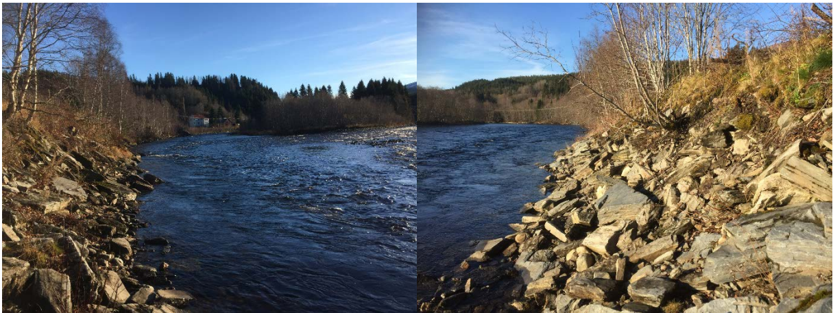
Figur 4: 4121 – Helgåa ved Åkerenget. Sikringstiltaket er i dag preget av manglende låsing av større stein som ligger ustabilt i skråningen.
