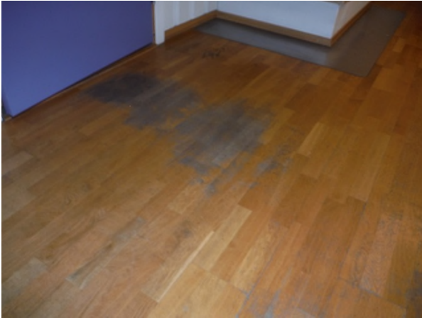
Figur 22: Slitt parkett på stubbloftsgulv, bygg A
