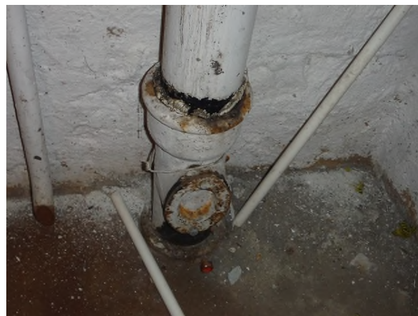
Figur 29: Gamle avløp/soilrør
