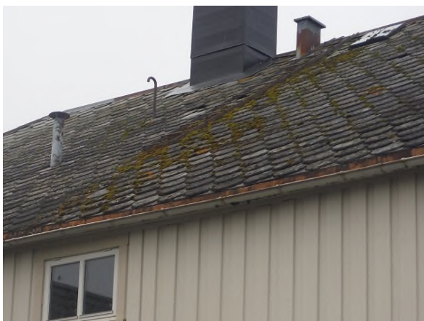
Figur 18: Gammelt skifertak må omlegges
