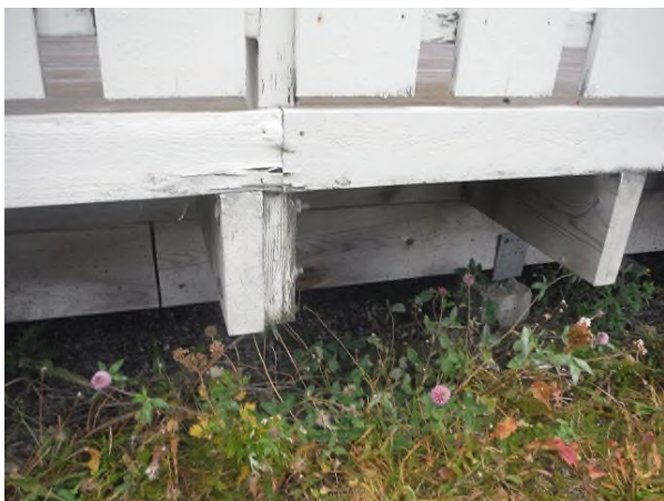
Figur 26: Råteskader altan
