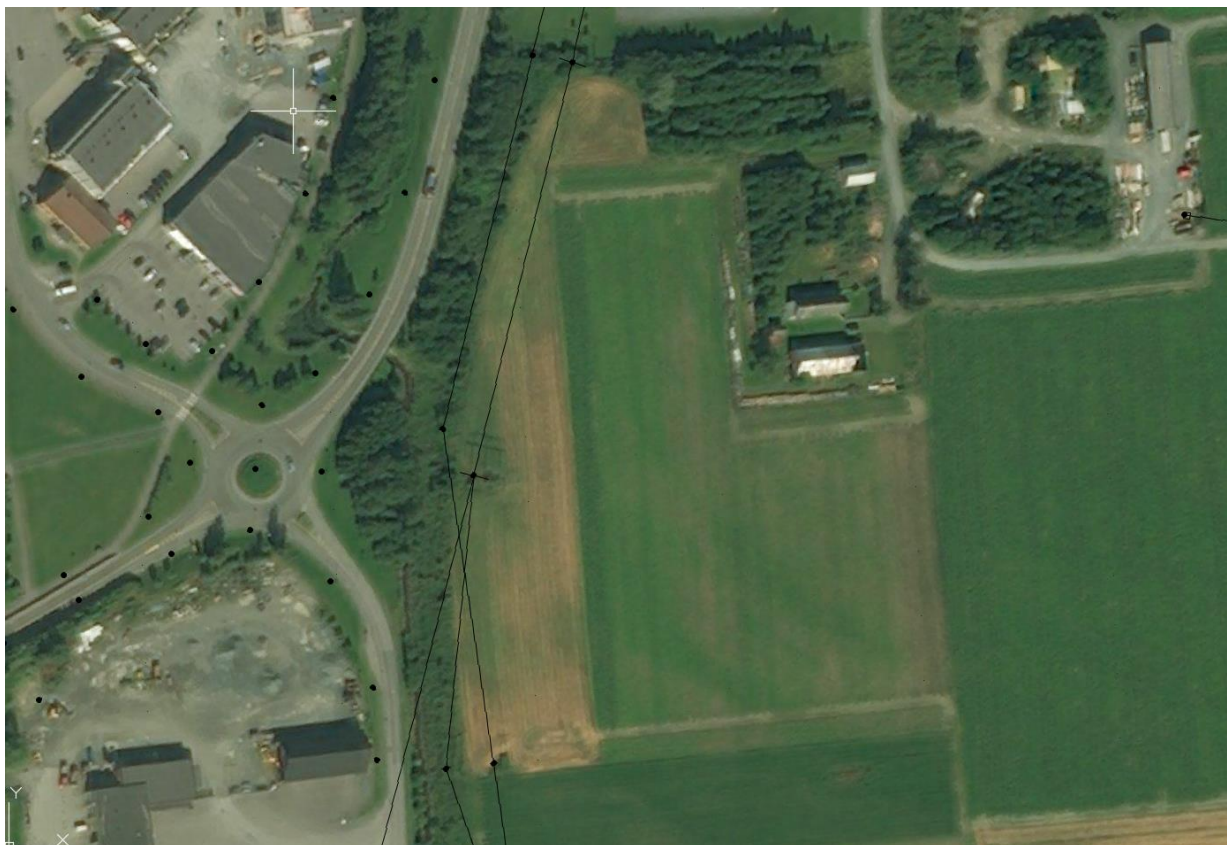
Høyspentledninger på området
