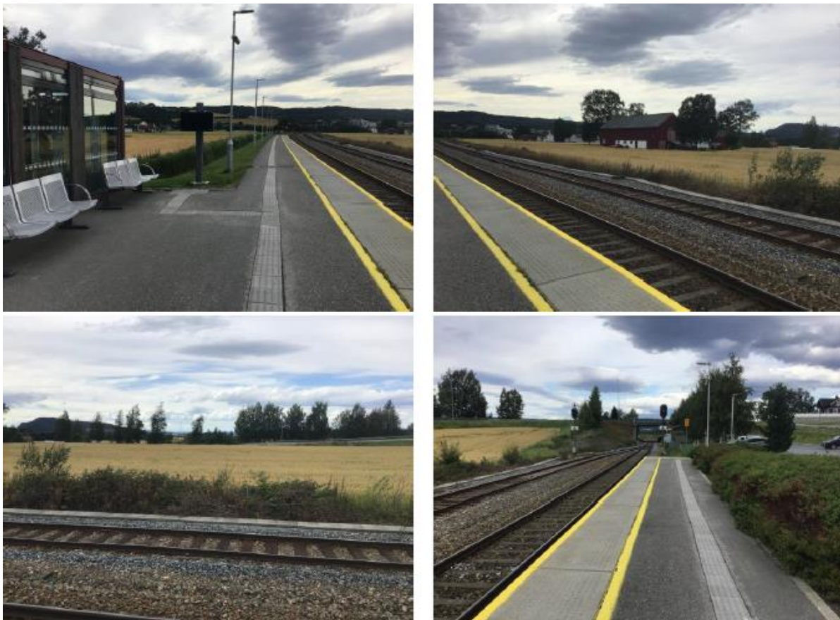
Figur 3-1 a-d 3a) Eksisterende plattform med belysning og sitteplasser. 3b-c) Smal kantsone med alminnelige skrotemarksarter og landbruksarealer der ny plattform skal komme. 3d) Adkomst til ny plattform kommer via vegfylling til venstre i bildet.
