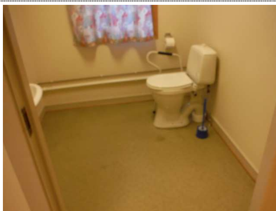
Bilde nr. 290-02 Div rom moden for totalrenovering i fløy A
