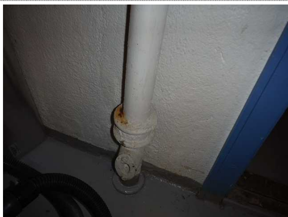
Bilde nr. 312-01 Gamle soilrør/bunnledninger fra 1955
