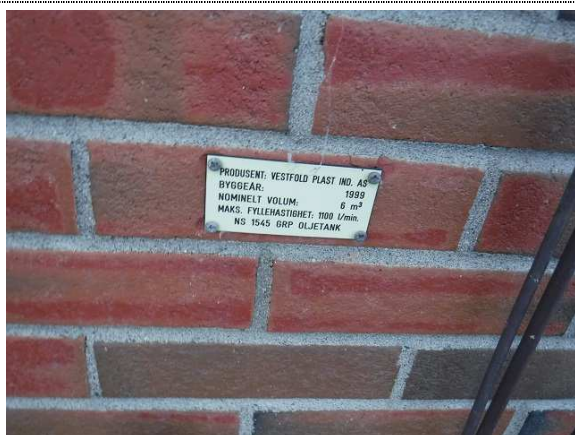
Bilde nr. 325-02 Nedgravd oljetank
