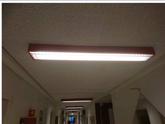
Bilde nr. 442-01 Lysrørarmaturer klar for utskifting
