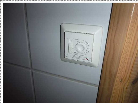
Bilde nr. 563-01 Romtermostater fløy D moden for utskifting
