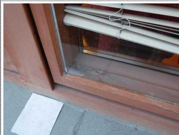
Bilde nr. 234-01 Vinduer m/integrert persienne klar for utskifting
