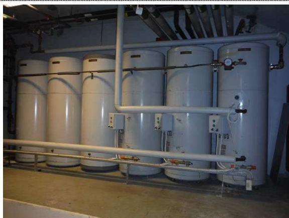
Bilde nr. 315-01 Berederinstallasjon med kort rest levetid
