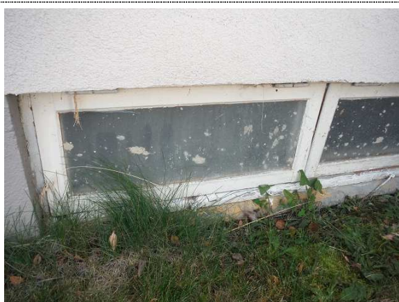
Bilde nr. 234-01 Gamle vinduer fra 1955
