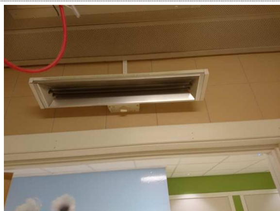
Bilde nr. 452-02 Gamle reflektorovner og eswa i tak
