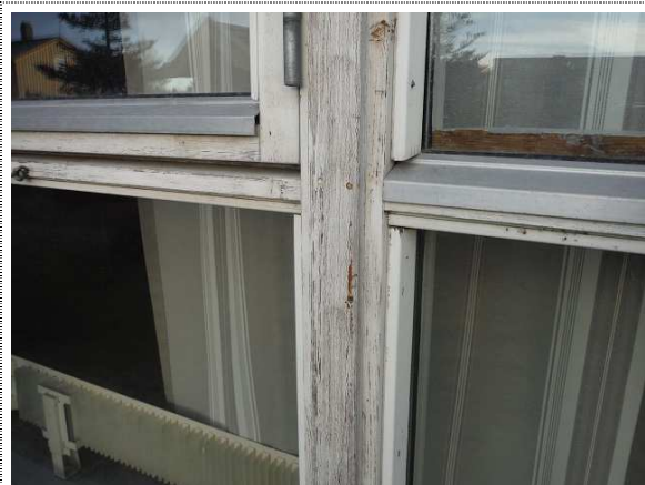
Bilde nr. 234-02 Vinduer, generelt kort rest levetid fløy C og D.
