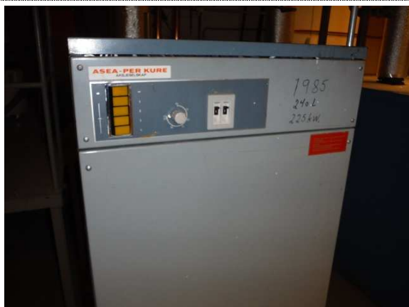
Bilde nr. 325-01 EI-kjel med kort rest levetid
