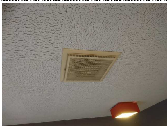
Bilde nr. 362-01 Gamle ventilasjonskanaler/ventiler
