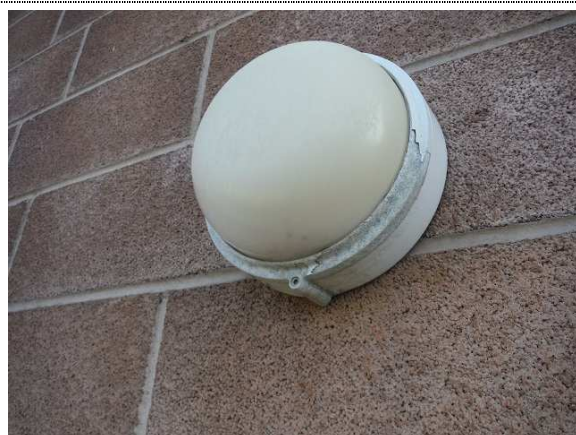
Bilde nr. 442-03 Utvendig belysning moden for utskifting
