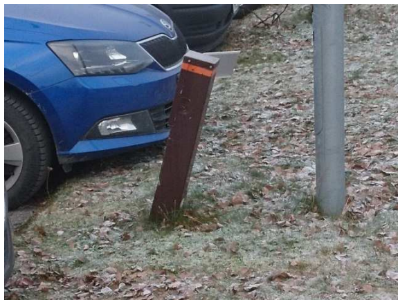
Bilde nr. 745-01 Motorvarmere påkjørt
