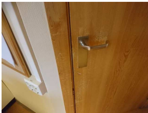
Bilde nr. 244-01 Slitte dører på beboerrom - bad
