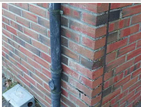
Bilde nr. 265-01 Taknedløp klar for utskifting
