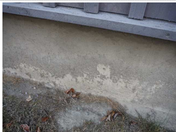
Bilde nr. 235-08 Avflasset puss på ringmur, fløy E
