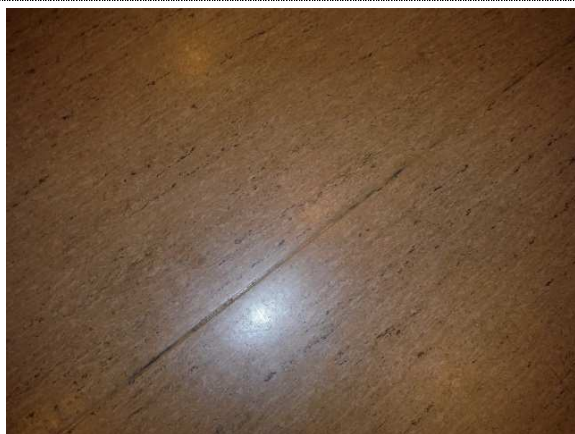
Bilde nr. 255-01 Slitte sveiser gulvbelegg
