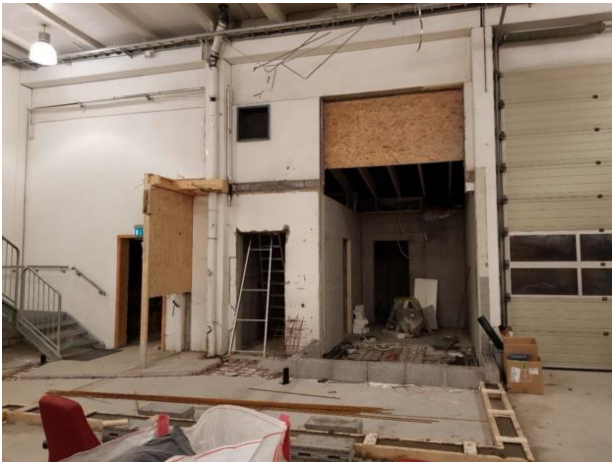
Ombygging Verdal brannstasjon
