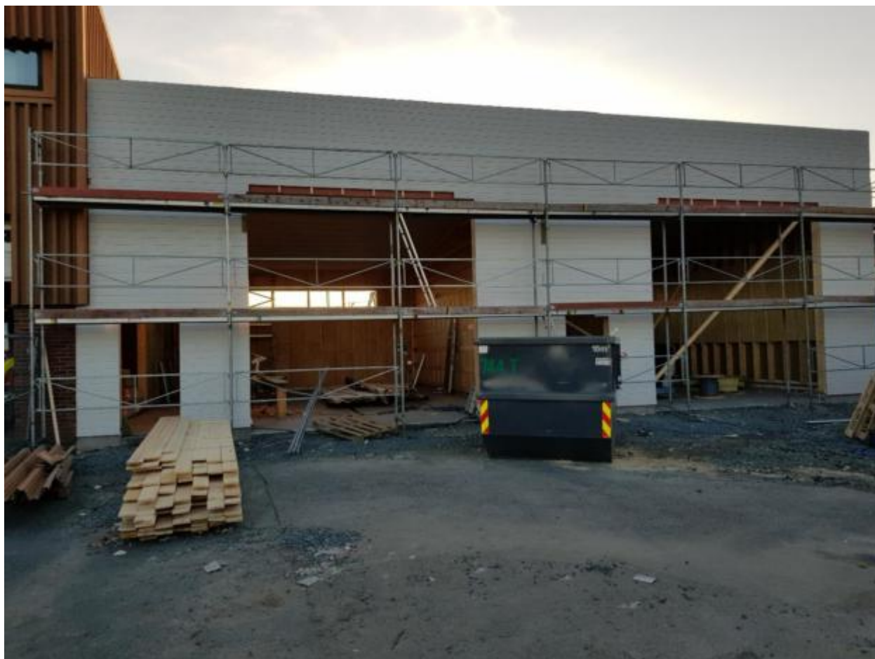
Nytt tilbygg til brannstasjonen på Frosta.
