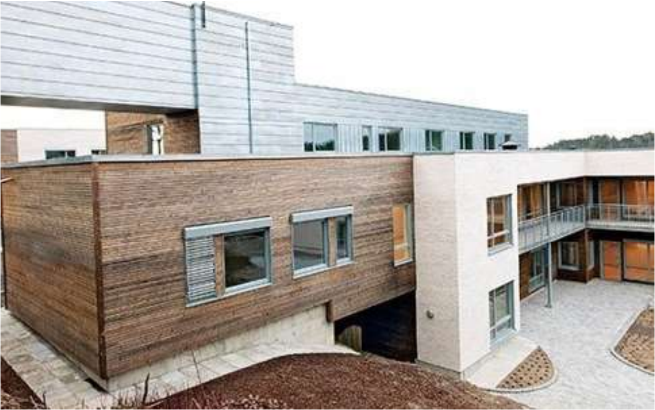
Bilde: Uterommene er organisert mot en naturlig kolle i landskapet, som skaper avskjermede uterom uten å bruke gjerder og hekker. Forbindelsesbroen kobler sammen den nye og den gamle delen. Foto Trond Joelson (bygg.no)
