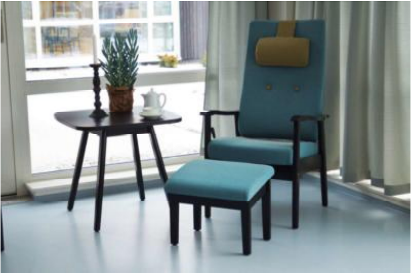
Over; Beboerrom med vinylgulv som ser ut som treverk Under: Gummigulv i blåfarge som ikke virker institusjonsaktig på grunn av fargesammen- setning. Foto Johanne Berg-Larsen
