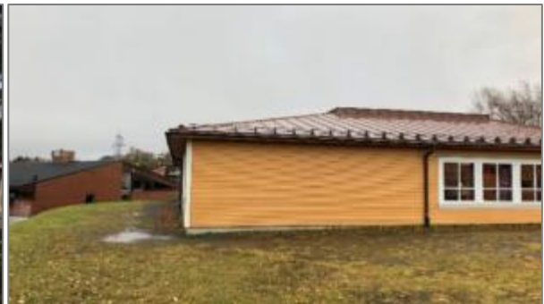
Figur 14 Eksisterende bygg for SFO og 1. klasse i forgrunnen. Hovedbygning i bakgrunnen. Foto: LINK arkitektur oktober 2018.
