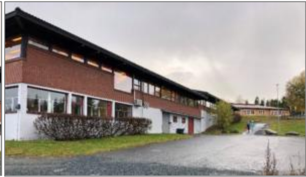
Figur 10 Eksisterende skolebygg – hovedbygning, sett fra nord mot øst/sørøst. SFO-bygg i bakgrunnen. Foto: LINK arkitektur oktober 2018.
