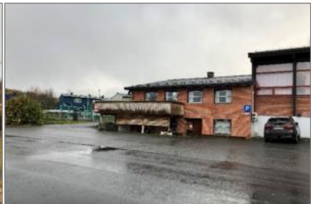
Figur 12 Eksisterende skolebygg / klubbhusdelen til Vinne I.L. sett fra nordvest. Foto: LINK arkitektur oktober 2018.
